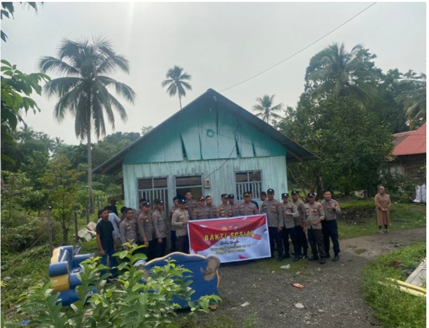
Tampak Memprihatinkan kondisi rumah warga Desa Bente yang dibedah Polres Morowali
