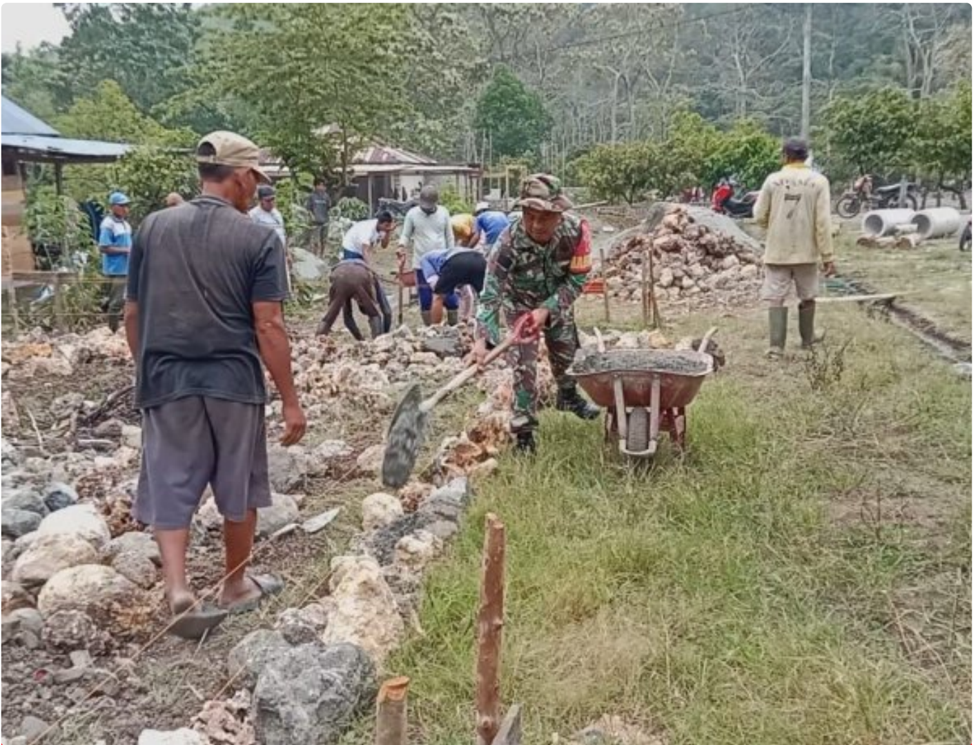
Gotong royong bangun pondasi rumah warga
